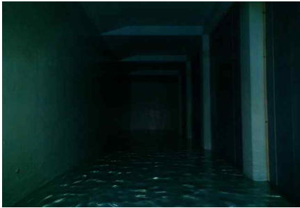
<배수지 1지 전경>
