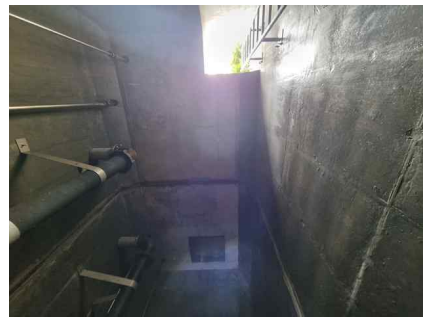
<통합유출밸브실 상부슬래브 상태양호>
