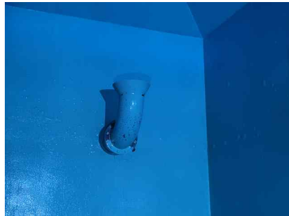
<1지 유입배관 현황>
