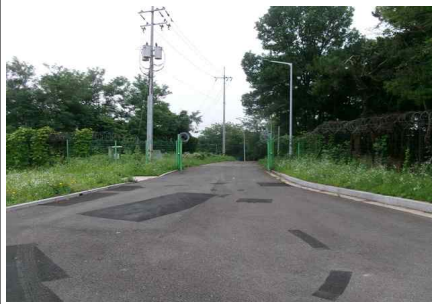
<진입로 포장 전경>
