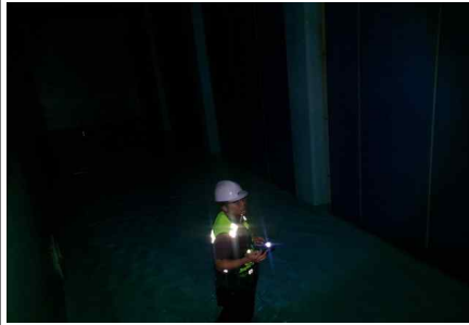
<내부 개별부재 외관조사>
