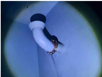
<2지 유입배관 현황>
